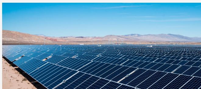
Inicio de construcción de parques solares
